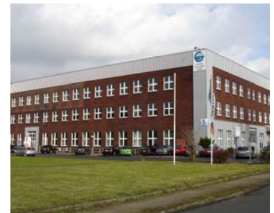
Bild 1: Halle B14 mit Eingang
